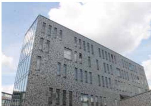
Knauber plante die Geothermie-Anlage des neuen Facharzt-Zentrums in Bonn-Beuel.
